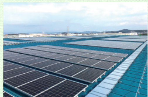
日本クロージャー小牧工場新プラスチック棟
