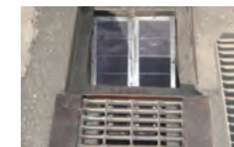
ペレット捕集用スクリーン設置例 (雨水枡)
